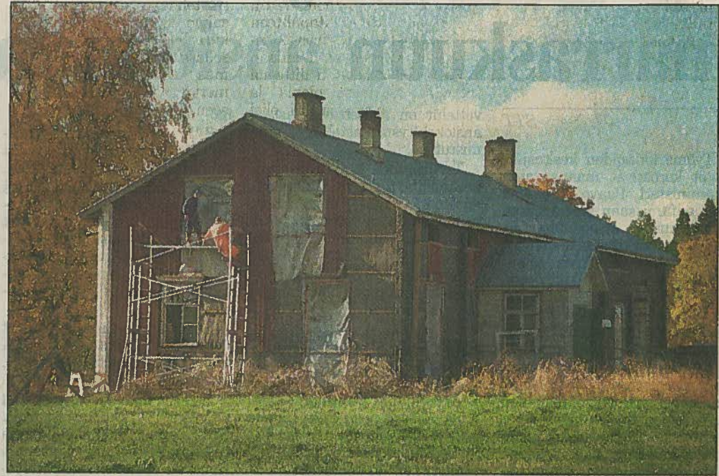
Vanhan Kurimon entisöinti aloitettiin satavuotiaan päärakennuksen ulkopuolisilla töillä. Pihapiirissä on kaikkiaan kymmenkunta rakennusta.
