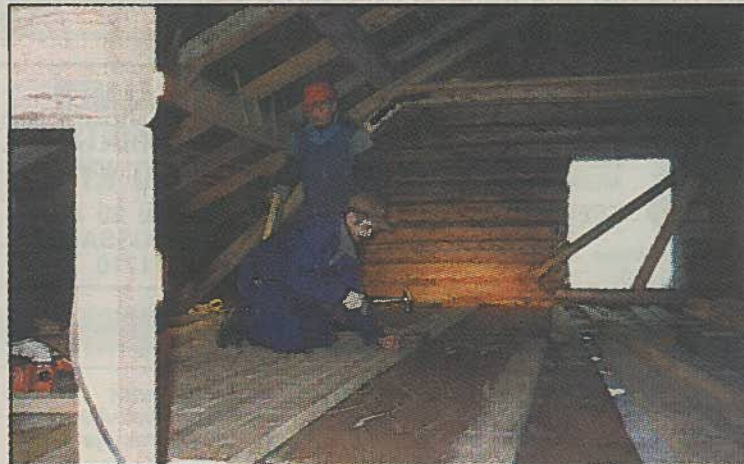
Voitto Seppänen ja Seppo Juntunen naputtelevat vintin lattialankuja paikoilleen.
