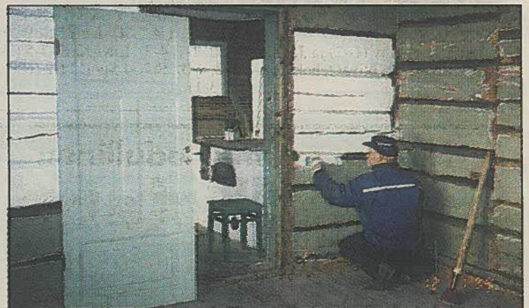
Reino Teeriniemi sivelee testimaalia Paratiisi-huoneen hirsiseiniin. Oviaukosta näkyy uusi pirtin puuhella. Peiliovi on jo saanut perinnevärin pintaansa.
